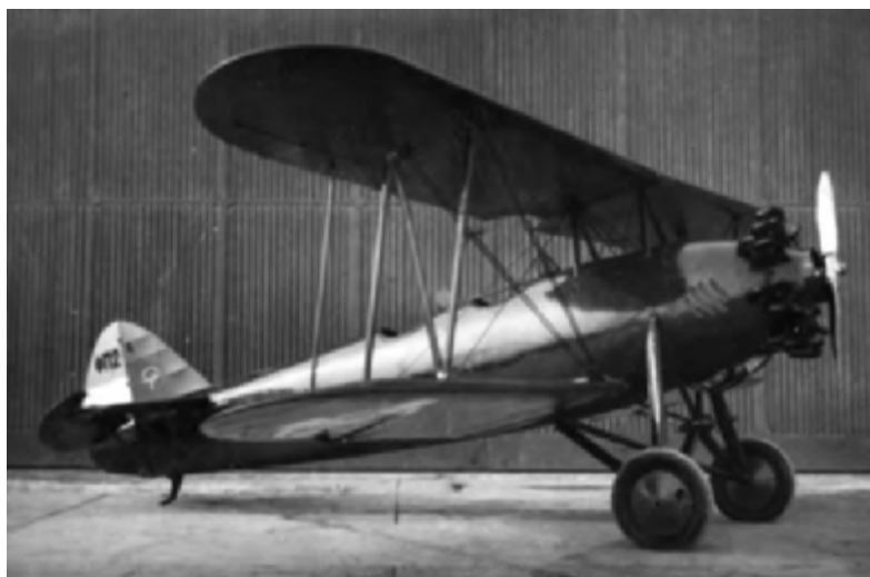
Прототип Змај ФП-2 (Физир-Станков) №1 предат је Команди ВВ у јануару 1934. године. Успешан прелазни авион, главни творац је инжењер Душан Станков (75 % радова у изради пројекта и разрада у фабрици). „Змај” је направио 65 серијских ФП-2 (1936-40), осам за Хрвате (током Другог светског рата) и седам за послератно Ваздухопловство (1945) (Radmio P. Givkovitch: L'Aéronautique Yougoslave )
